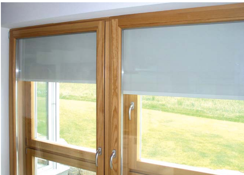
Im Zwischenraum von innerem und äußerem Fenster mussten die Antriebe der Rollos Temperaturen zwischen 60 und 80 Grad Celsius standhalten.
